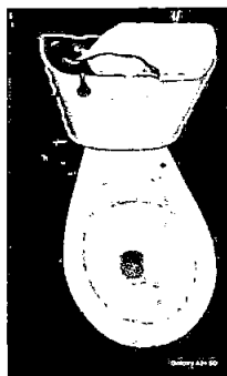
Foto 3: Estado de las tasas de los baños
