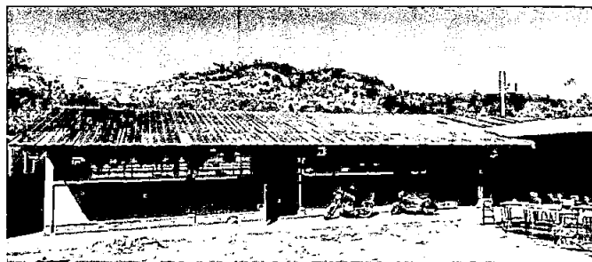
Foto 4: Estado de la lámina del módulo 2
